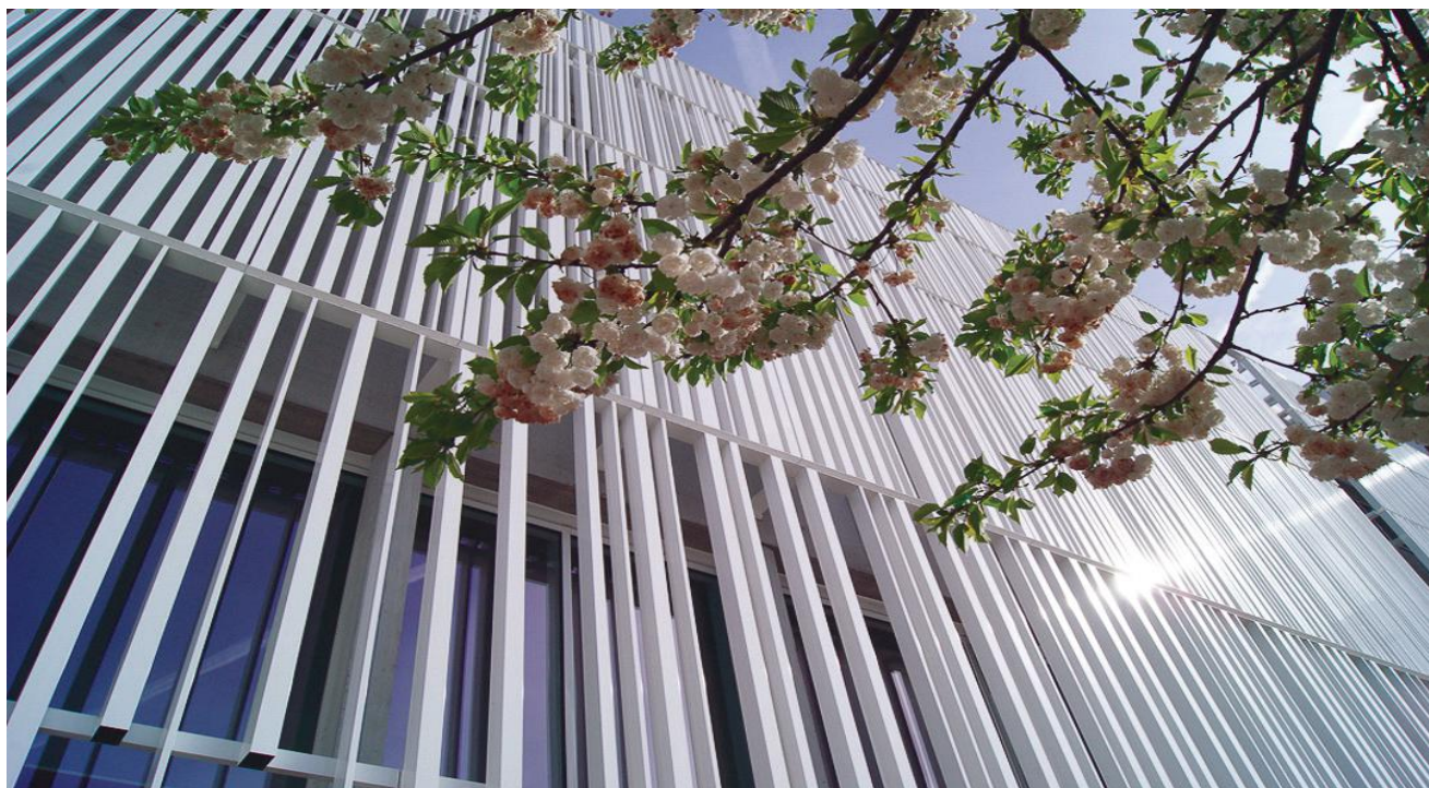
Détail des lames de métal du Centre des colloques © Campus Condorcet
