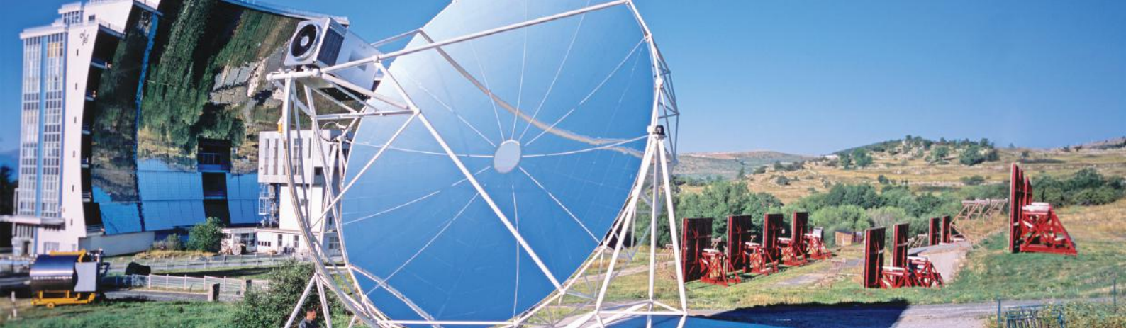
Four solaire d'Odeillo de 1 000 kW et au premier plan, le module de production d'électricité par moteur Stirling (10 kW). © CNRS Photothèque - OLALDE Gabriel
